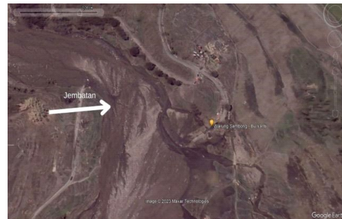
Gambar 8. Kondisi terputusnya jembatan penghubung Dusun Klangon dan Dusun Sedawun di Desa Pandansari akibat terjangan banjir lahar dingin di Sungai Sambong. Sumber: Google Earth Pro.
