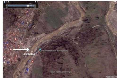
Gambar 7. Jembatan penghubung beberapa dusun di Desa Pandansari dengan Waduk Selorejo yang terputus akibat terjangan banjir lahar di Sungai Sambong. Sumber: Google Earth Pro.
